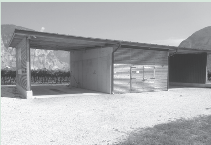
Centro lavaggio automezzi agricoli a Mezzocorona
